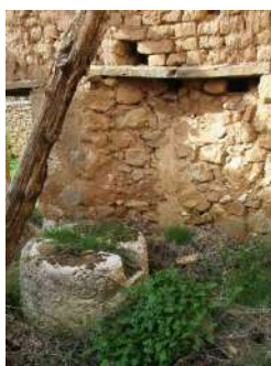
Pilón y rebaje del muro
