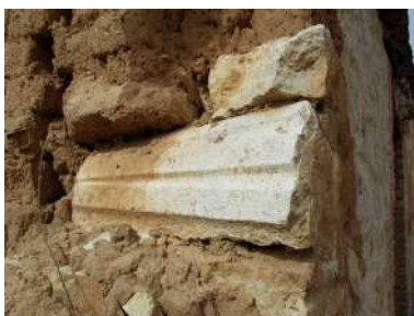
Enjarje en el muro de fachada
