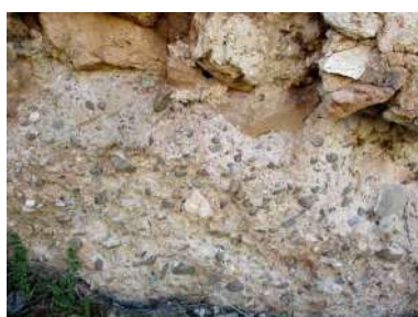
Restos de la pila
