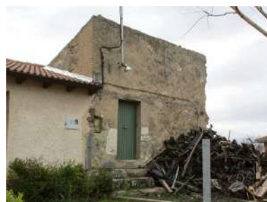
Portajón y cargadero
