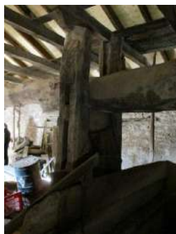
Viga y vareñas de entre pilas
