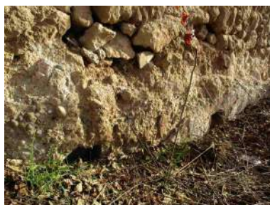
Restos de la panera lateral
