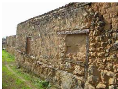
Portajón de descarga
