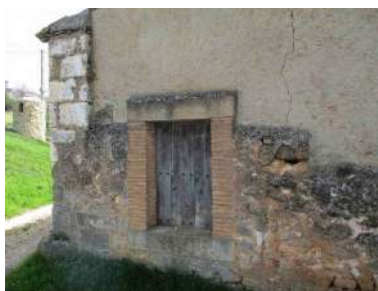
Cargadero y portajón de descarga
