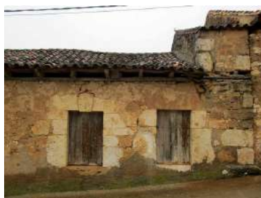
Portajones y cargadero
