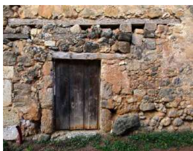
Cargadero y portajón de descarga
