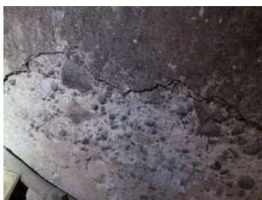
Revestimiento de la pila
