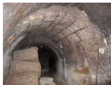
Bóveda en sillería con zarcera B
