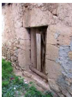
Portajón de descarga
