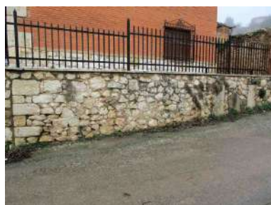
Restos fachada del lagar
