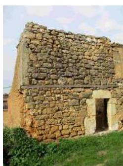
Cargadero y portajón de descarga
