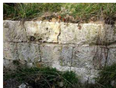
Sillería en la pila de la uva
