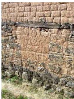
Portajón de descarga
