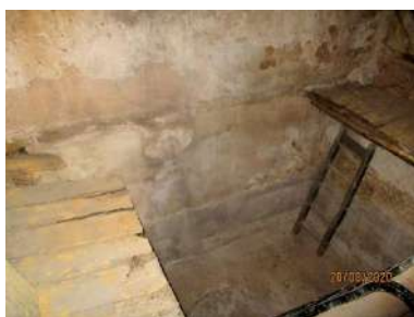
Pila del mosto y canilla
