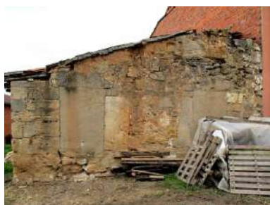
Portajones y cargadero
