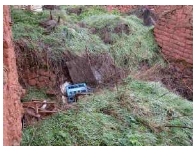
Panera de entre pilas
