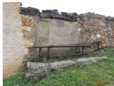
Portajón y descargadero
