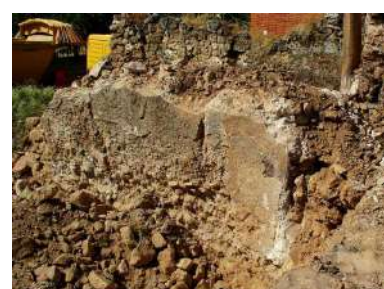
Revestimiento de la pila
