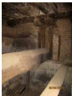
Pila de la uva, viga y cargadero
